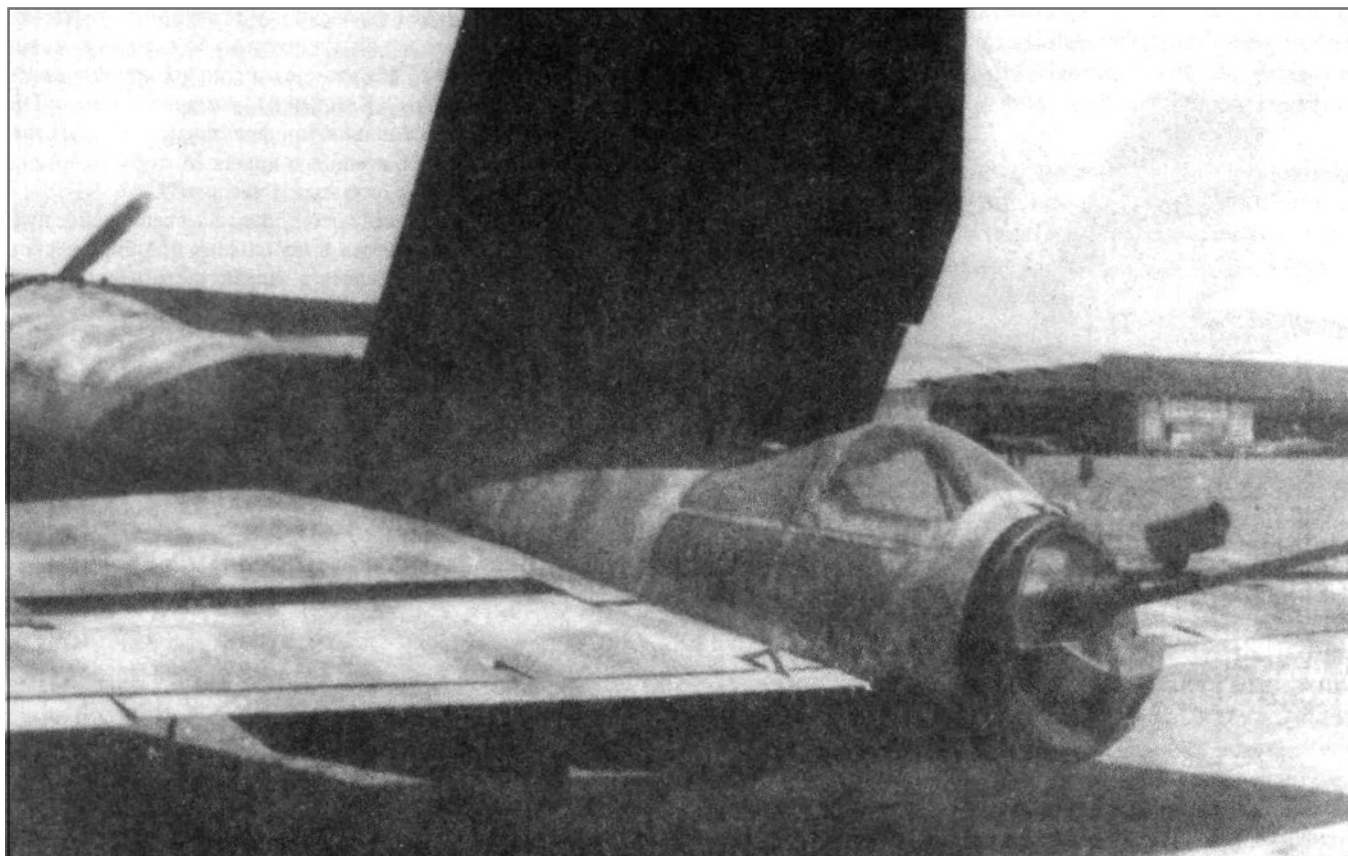
Хвостовая огневая точка на He 177A-3 из KG 100, оснащенная пушкой MG 151/20.
